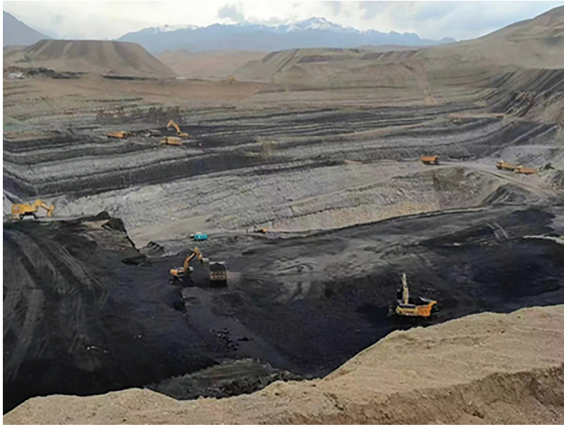
施工团队进行挖土及拨离工作
